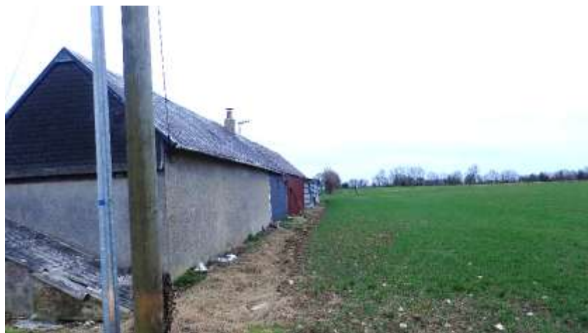
Figure 150 – Protéger, permettre la transformation ... une gestion des bâtiments agricoles compliquée
