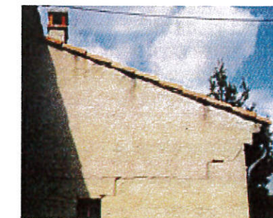
Exemple : Fissurations dues à la sécheresse
