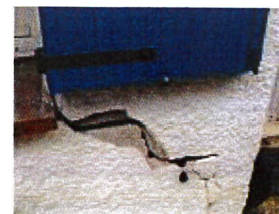
Exemple : Fissurations dues à la sécheresse
