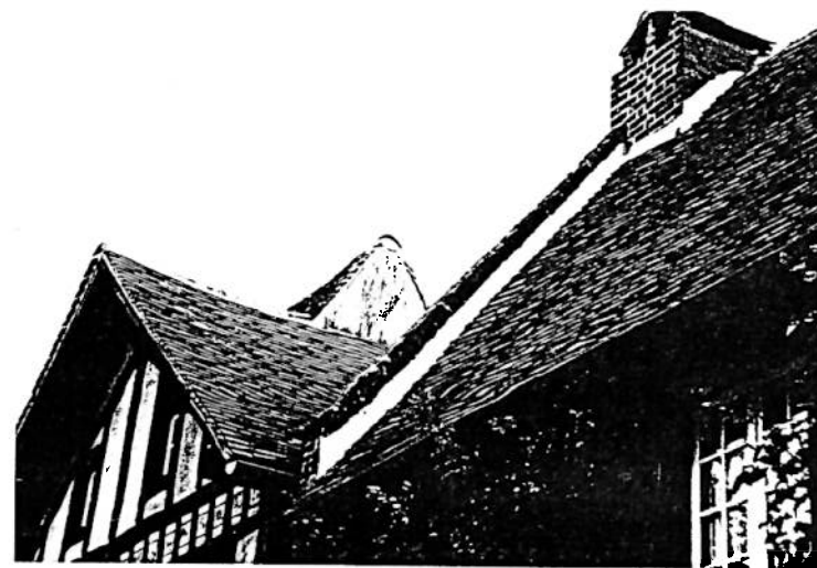
les toits de tuile plate petit moule
