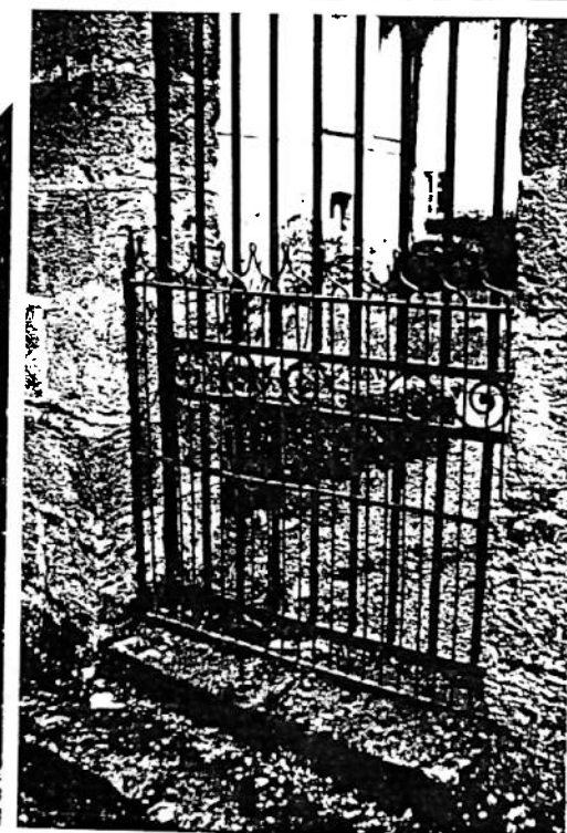
les portails de ferronnerie
