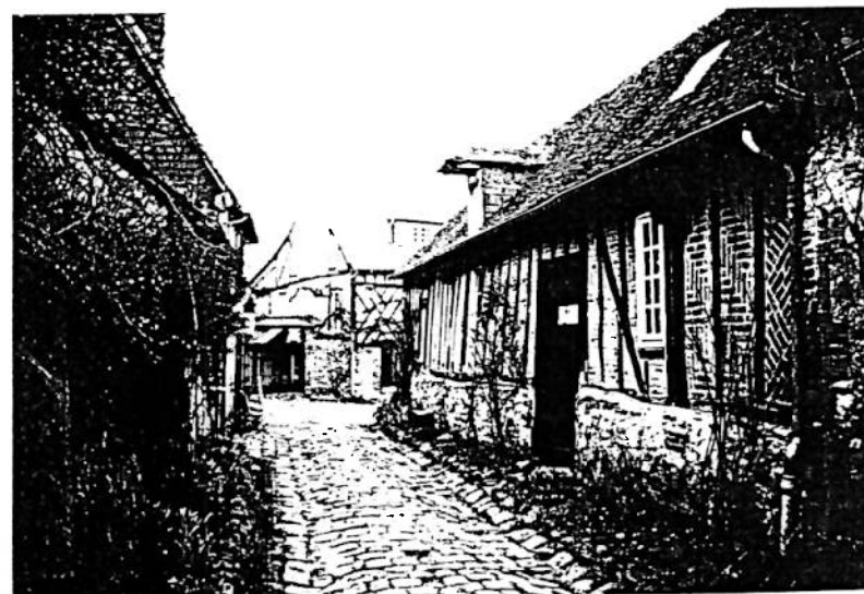
pan de bois remplissage brique, colombages ouvragés
