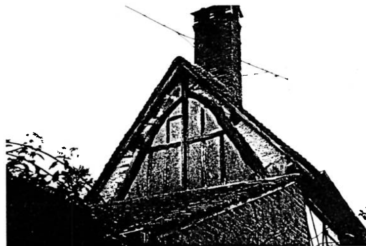
charpente à ferme latine
